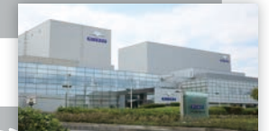
国内/ゆめが丘工場
